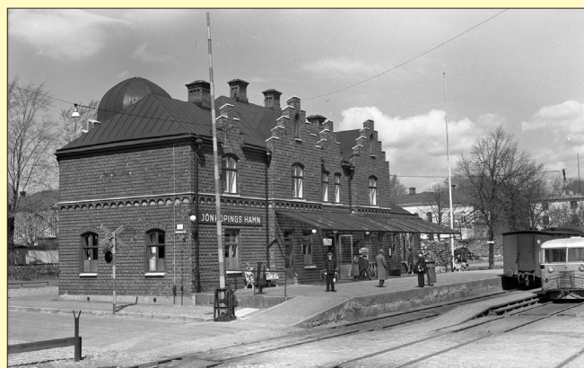
Jönköpings hamnstation vid Munksjön. Foto: Järnvägsmuseet, Digitalt museum.
